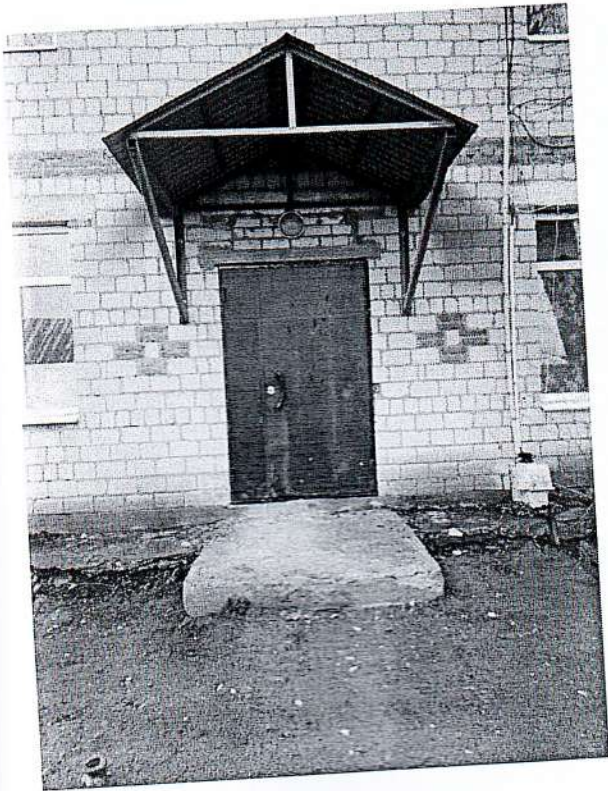
Фотография №23 Пути эвакуации.
