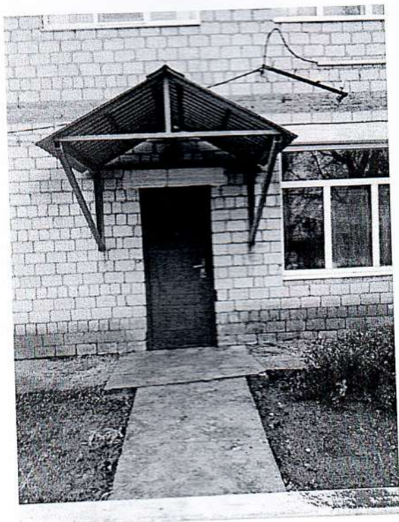
Фотография №22 Пути эвакуации.
