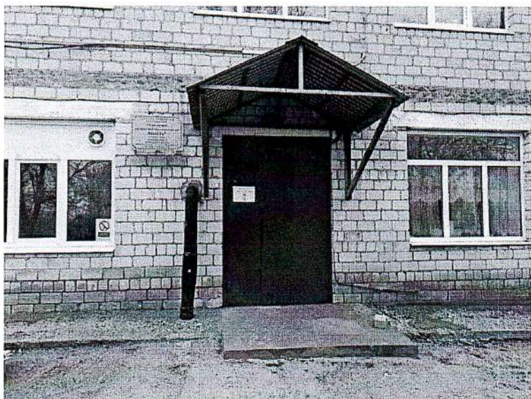
Фотография № 3 Вход в здание.
